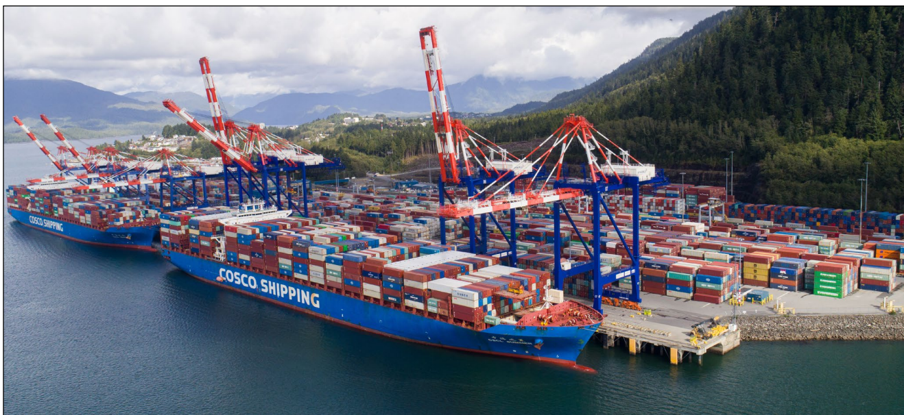
VUE EST DU TERMINAL DE FAIRVIEW (2021)
