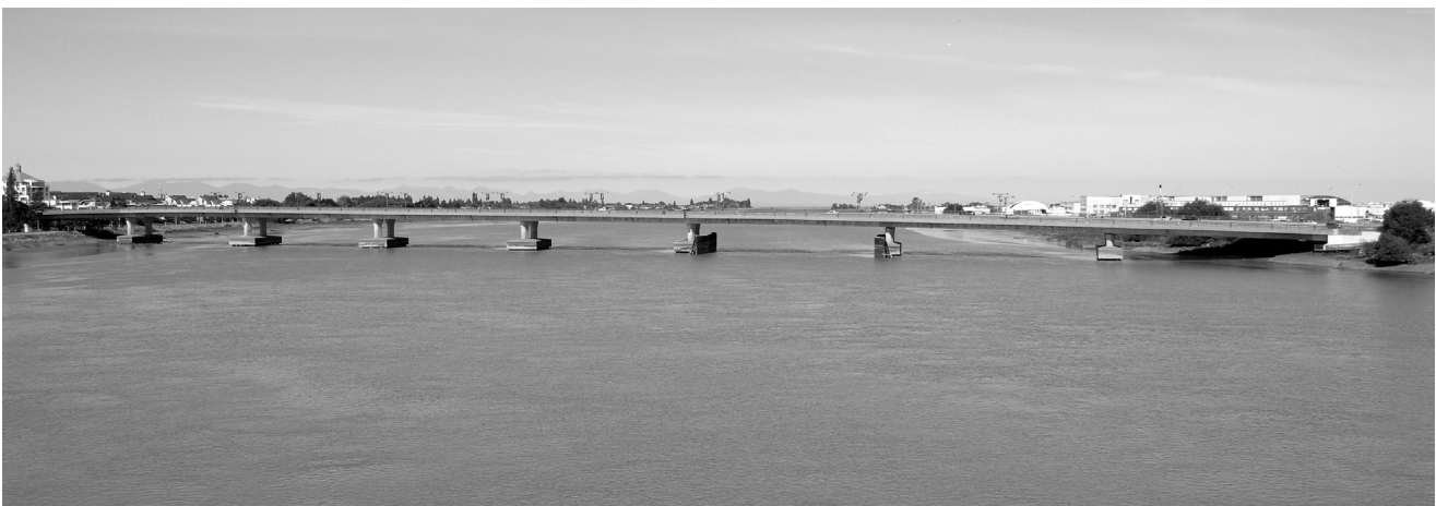
PONT DE LA ROUTE N° 2 (2007)
