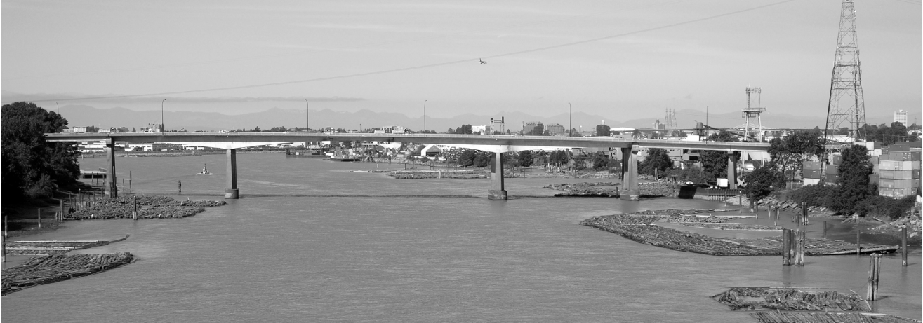
PONT FERROVIAIRE DU CANADIEN NATIONAL (2007)
