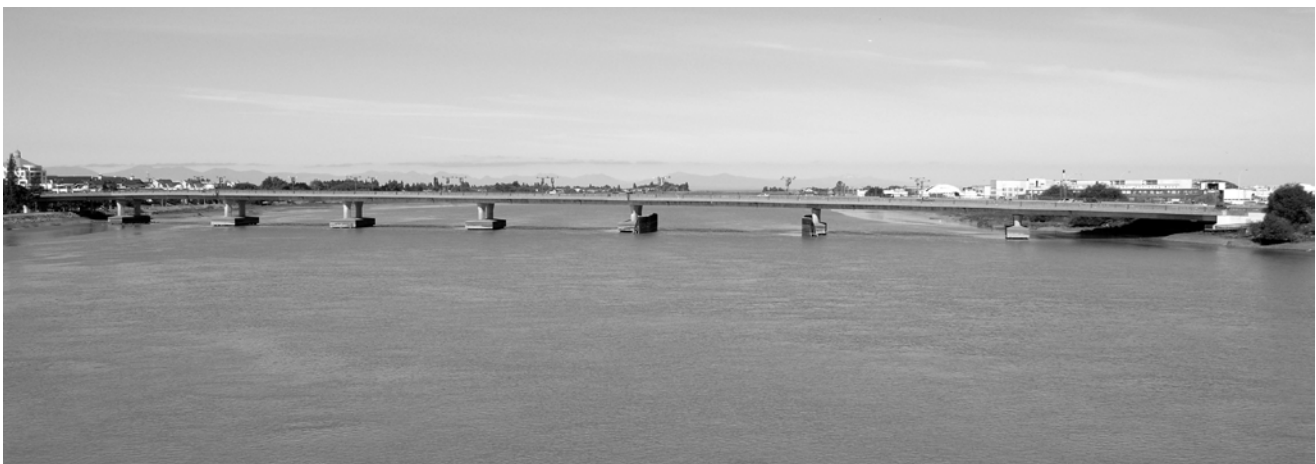
PONT DE LA ROUTE N° 2 (2007)
