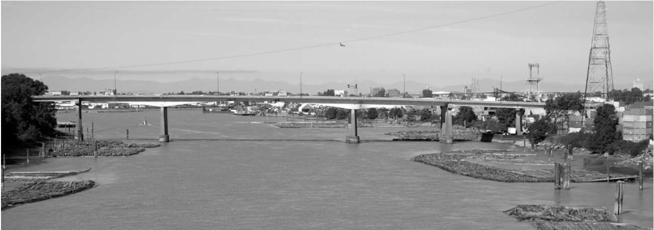
PONT FERROVIAIRE DU CANADIEN NATIONAL (2007)
