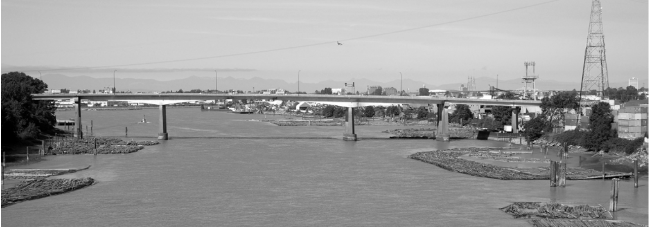
PONT FERROVIAIRE DU CANADIEN NATIONAL (2007)
