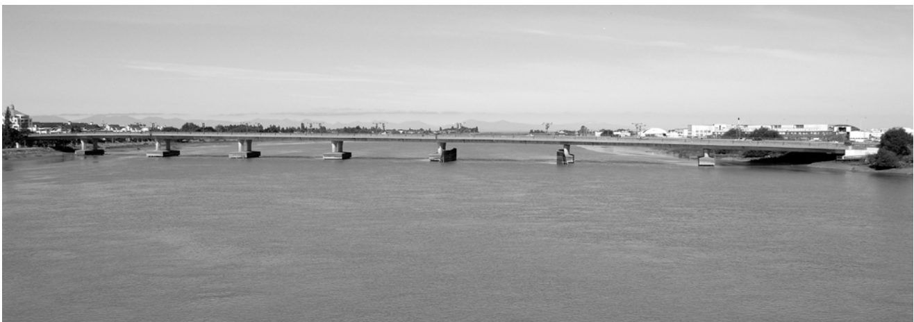
PONT DE LA ROUTE N° 2 (2007)
