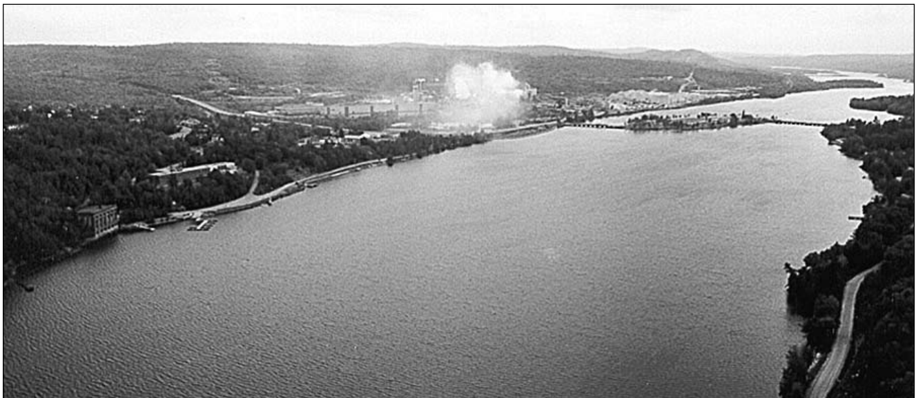
TÉMISCAMING VUE DU NW (2001)
