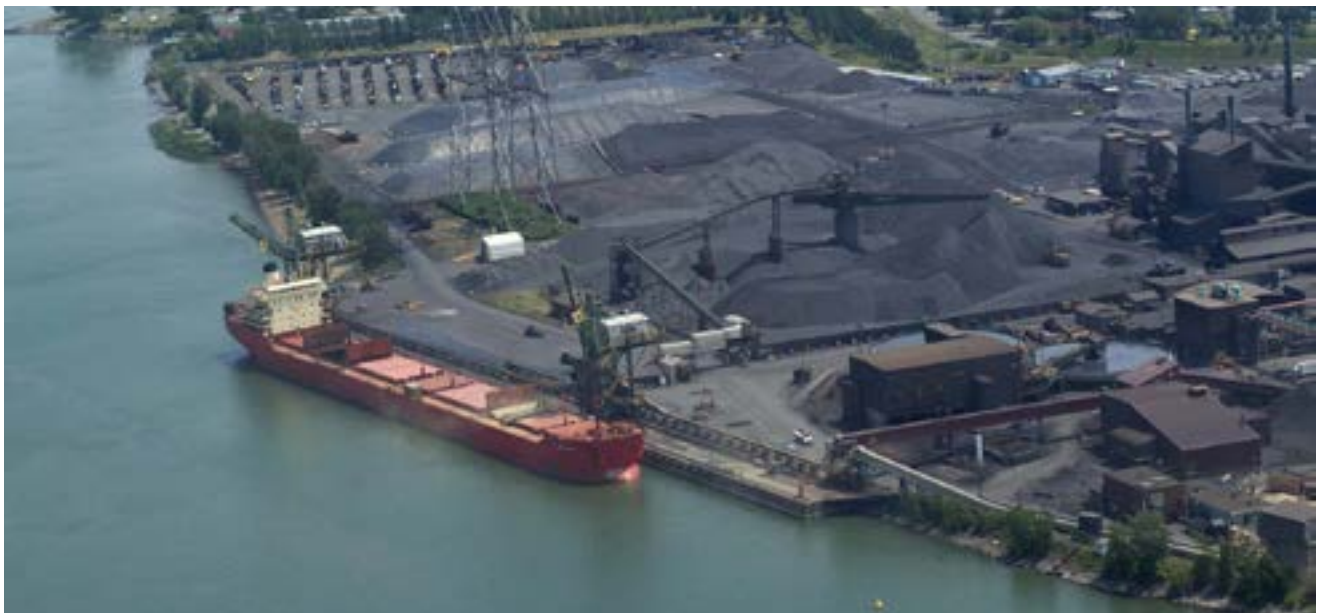
PORT DE SOREL, POSTES 20 ET 21 (2007)
