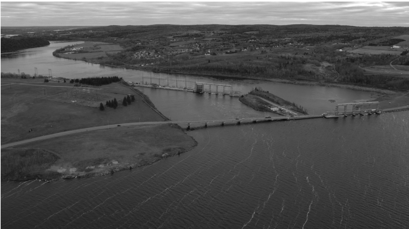
BARRAGE DE MACTAQUAC (VUE DE L'OUEST) (2006)
