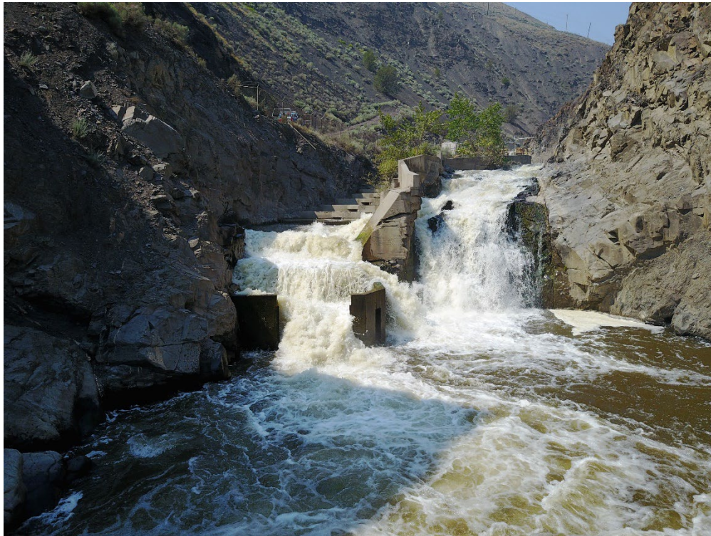
Figure 22. Passe à poissons de la rivière Bonaparte qui facilite la montaison du chinook.
