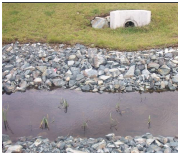
Figure 3.15 L'enrochement prévient l'érosion.
