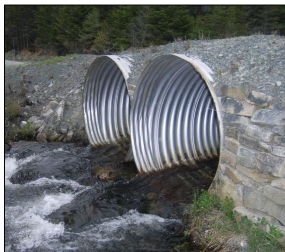
Figure 3.21 Installation de ponceaux à tuyaux parallèles étagés.
