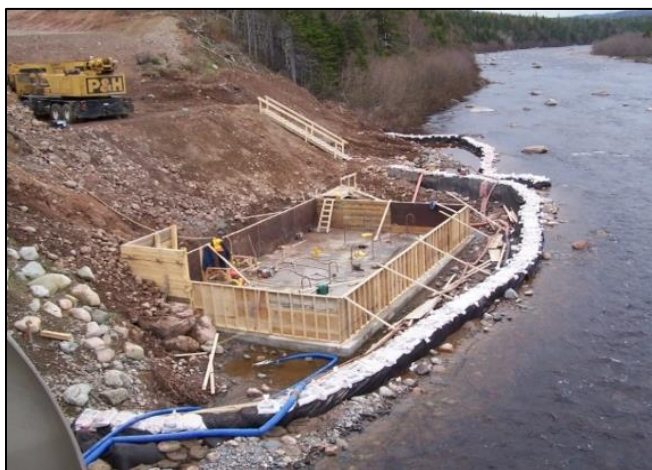
Figure 3.37 Des batardeaux peuvent être utilisés pour isoler les zones d'ouvrage du bord du cours d'eau de l'écoulement du cours d'eau.
