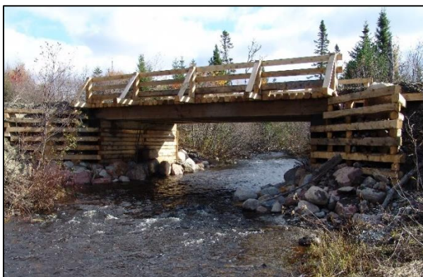
Figure 3.31 Il faut utiliser du bois non traité ou traité sous pression pour la construction de caissons en bois.
