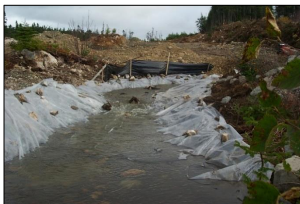
Figure 3.9 Les bassins de décantation doivent être tapissés d'un matériau imperméable, comme du plastique, afin d'empêcher la production de limon à partir du bassin de décantation excavé.
