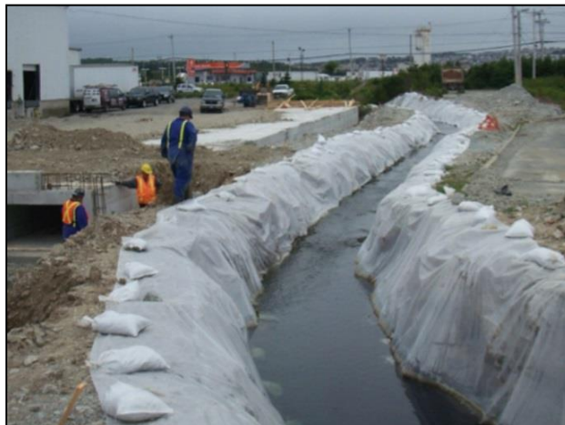
Figure 3.40 Les canaux de dérivation temporaires doivent être recouverts de plastique lesté de pierre.
