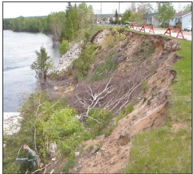
Figure 3.13 Les activités d'aménagement peuvent déstabiliser les berges, ce qui entraîne leur érosion et une sédimentation considérable des cours d'eau.
