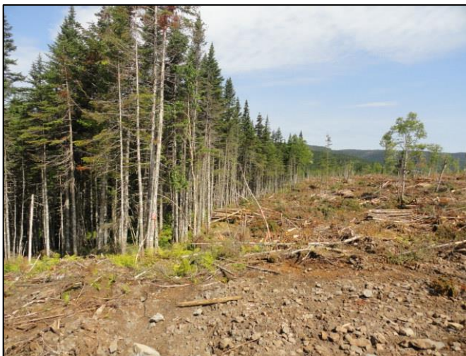
Figure 3.35 Le défrichage et l'essouchement des emprises sont souvent associés à de nombreux projets de construction, y compris des routes, des pipelines et des lignes de transport d'électricité.
