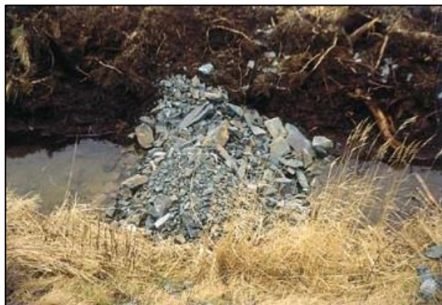
Figure 3.5 Les bermes filtrantes peuvent être construites à partir de divers matériaux facilement accessibles, y compris des roches.
