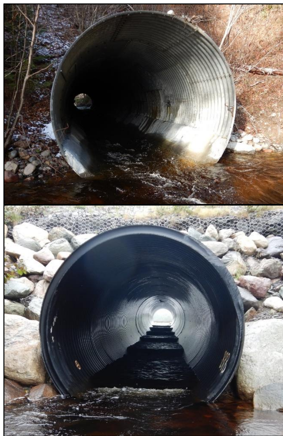
Figure 3.28 Exemples de ponceaux réparés (l'image du haut montre l'armature du béton et l'image du bas montre un revêtement en PEHD).
