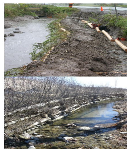
Figure 2. Ouvrages riveains pendant la construction (en haut) et après (en bas). Photo : MPO.
