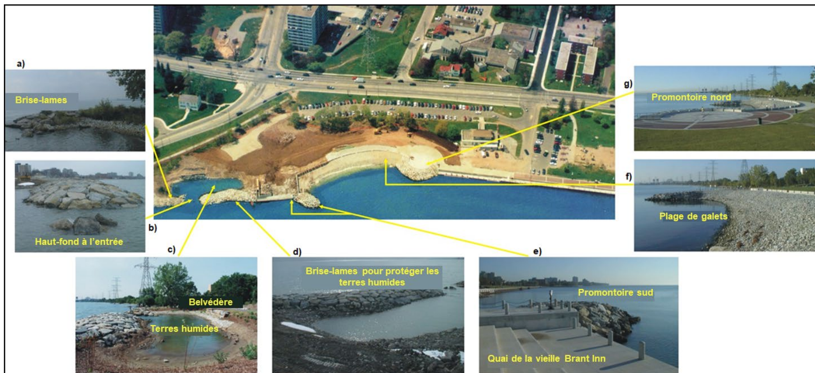
Figure 7. Nœud de Brant Inn, Burlington (Ontario), photographies du site après la construction montrant a, b, c, d) la terre humide nouvellement construite avec a) et d) des brise-lames pour protéger la terre humide, b) le haut-fond protecteur construit à l'entrée de la terre humide, et c) la nouvelle terre humide avec un belvédère; f) la nouvelle plage de galets entre e) la vieille jetée reconstruite de la Brant Inn avec un promontoire en enrochement au sud et g) un promontoire en enrochement au nord.
