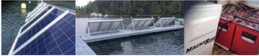
Composantes du système d'énergie renouvelable installées au site de Kyuquot SEAFoods Ltd. : panneaux solaires modulaires sur un quai (à gauche et au milieu), ainsi que des batteries de stockage et de l'électronique (à droite). Photo : Stephen Cross (UVic)
