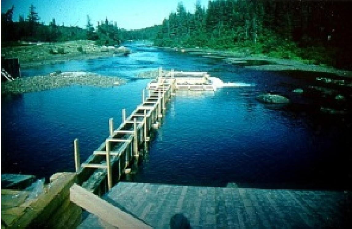
Figure 1. Exemple de canal volontaire. Ce chenal expérimental temporaire a été construit à l'installation de recherche de Noel Paul dans le centre de Terre-Neuve, au Canada (photo de M. Colavecchia). Les données sur la nage publiées, qui ont été obtenues de cette façon et au moyen d'autres types de configurations expérimentales, ont été incluses dans la base de données compilée et utilisée dans la présente étude afin d'élaborer les courbes de performance natatoire des poissons.
