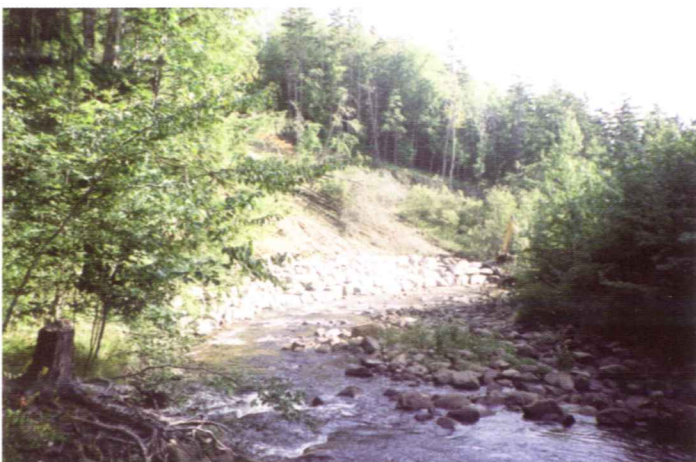
Restauration de l'habitat - stabilisation des berges.
