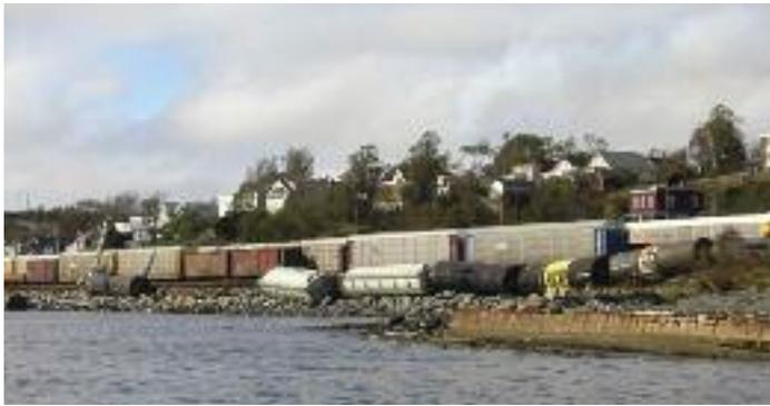
**Figure 5.** Le port d'Halifax après le passage de l'ouragan Juan : les vagues qui se sont propagées à l'intérieur du port à marée haute ont affouillé l'assise de la voie extérieure de la cour de triage du Canadien national le long du bord de mer de Dartmouth, faisant chavirer les wagons et en basculant même dans le port.
