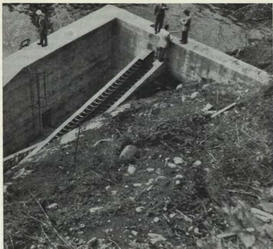
Échelle à poissons du type Denil sur la rivière Rainy, en Colombie-Britannique.
