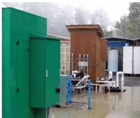
Module de conditionnement pour l'eau d'un système d'élevage marin (refroidisseur d'eau, tableau de commande et de surveillance, alarmes, équipement d'osmose inverse). Crédit : Linda Hiemstra (Sable Fish Canada Ltd.)
