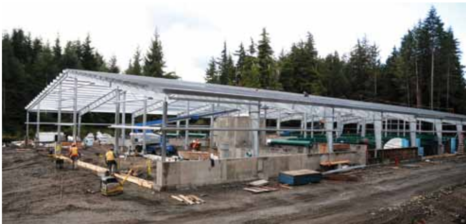
Système en construction d'aquaculture terrestre en recirculation de la Première Nation 'Namgis. Crédit : Jackie Hildering (K'udas Limited Partnership)
