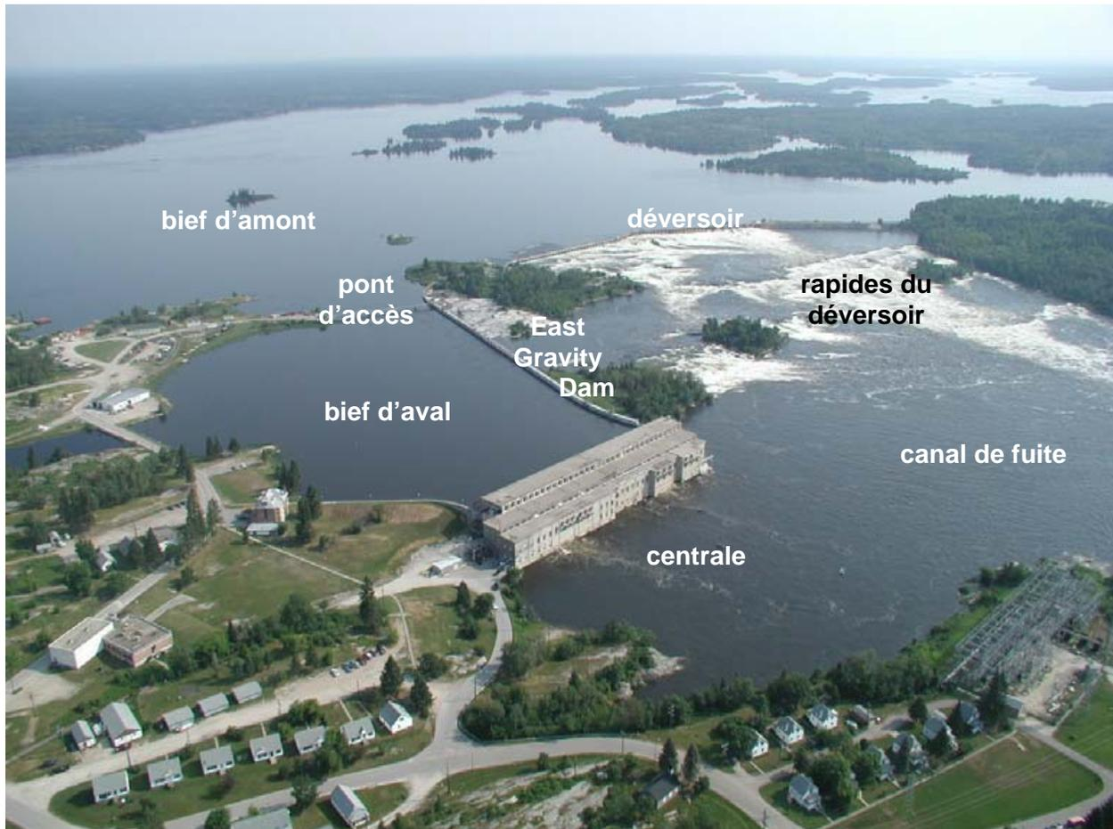
Figure 2. Configuration actuelle de la centrale hydroélectrique de Pointe-du-Bois (photographie fournie par Hydro-Manitoba).
