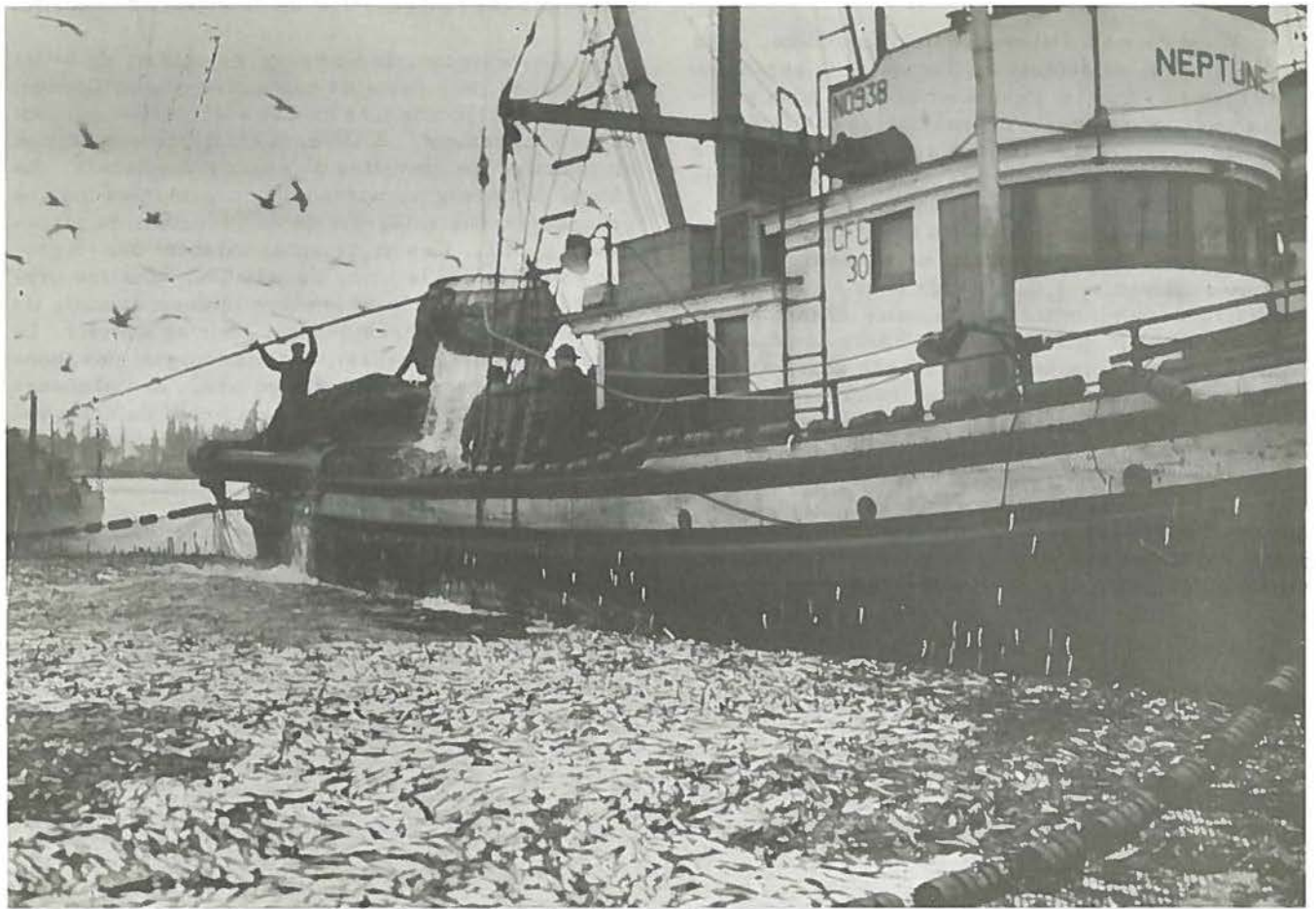
Une épuisette géante, actionnée par un treuil mécanique, cueille par milliers les harengs pris dans le filet. Mouettes et goelands tournoient autour du navire, en quête d'une proie facile.
