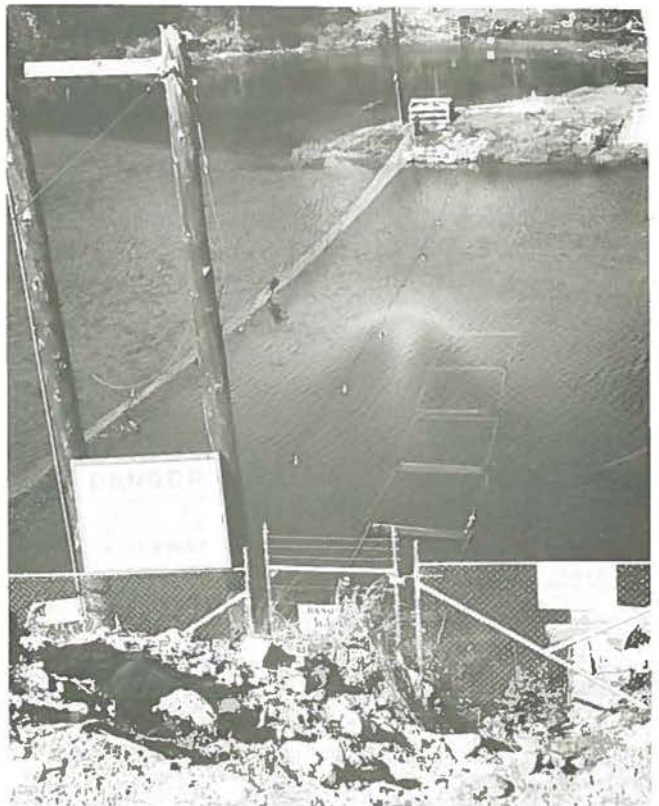
Barrière électrique sur la rive est de la Chippewa, tributaire du lac Supérieur, en 1965.
