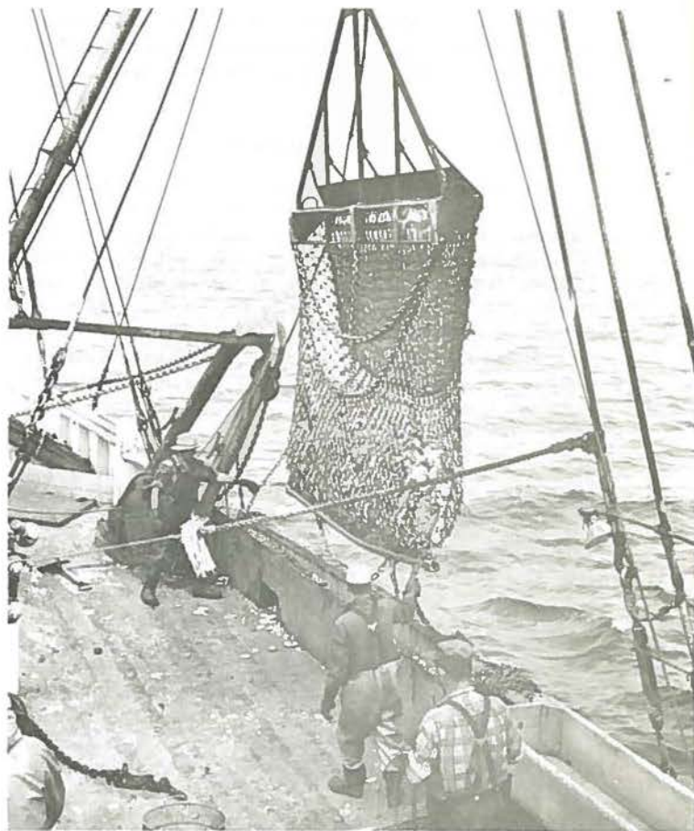
Fig. 5 – Relevage d'une drague de 12 pieds, après un trait de 20 minutes sur le banc Georges; la drague vide pèse 1,400 livres, et peut contenir jusqu'à 8,000 livres de pétoncles.
