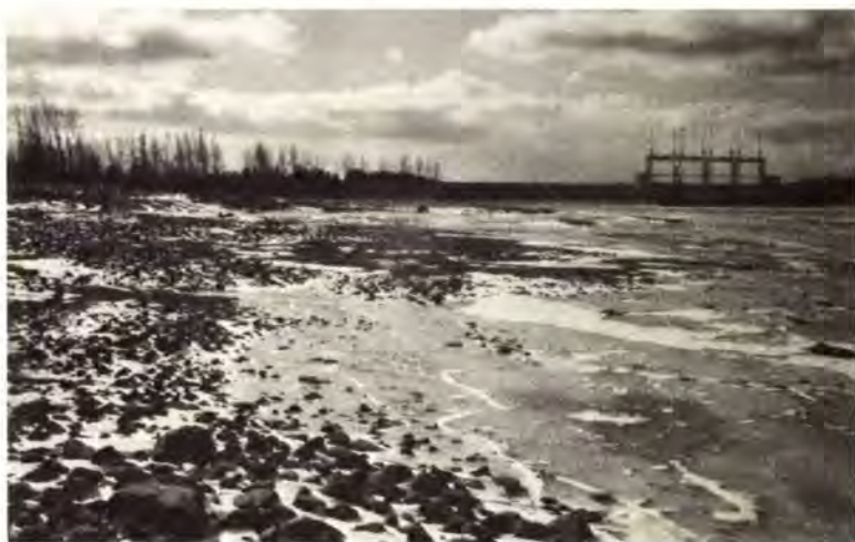
FIG. 7 Le barrage Shand, un barrage-poids en terre, et le réservoir Belwood, sur la rivière Grande près de Guelph (Ontario); on peut voir la zone de rabattement du plan d'eau (photo R.M. Baxter).
