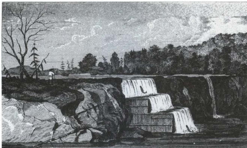
Chute d'eau canadienne : l'une des premières échelles à poissons du Canada, utilisée à Québec, vers 1855. Source : The Canadian Journal of Science, Literature, and History , n° VII, p. 2 [1857].
