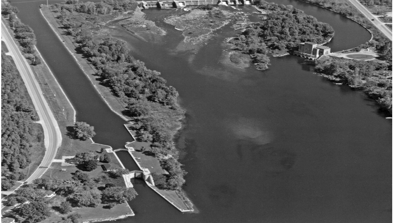
ÉCLUSE CAMPBELLFORD (ÉCLUSE N° 13) (2015)
