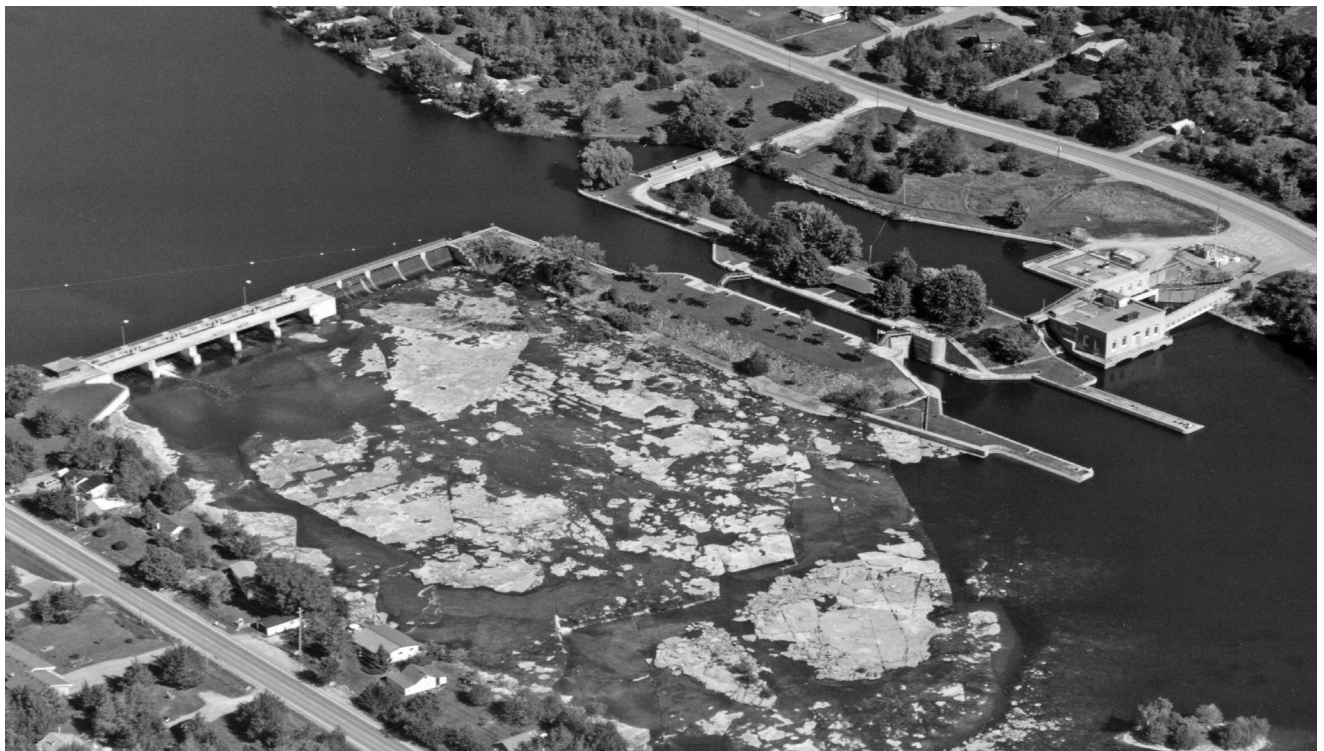
ÉCLUSE CROWE BAY (ÉCLUSE N° 14) (2015)
