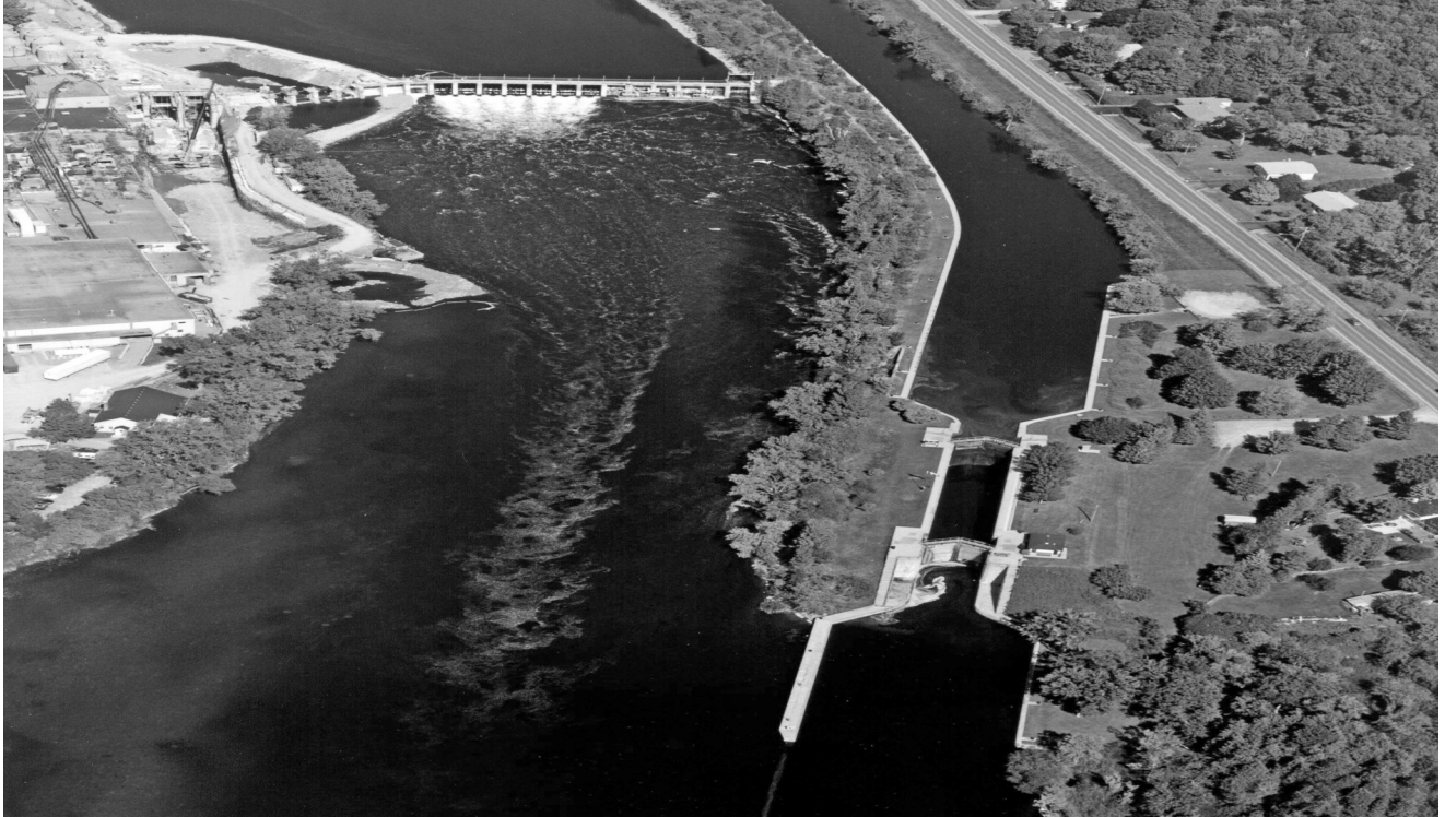
ÉCLUSE GLEN MILLER (ÉCLUSE N° 3) (2015)
