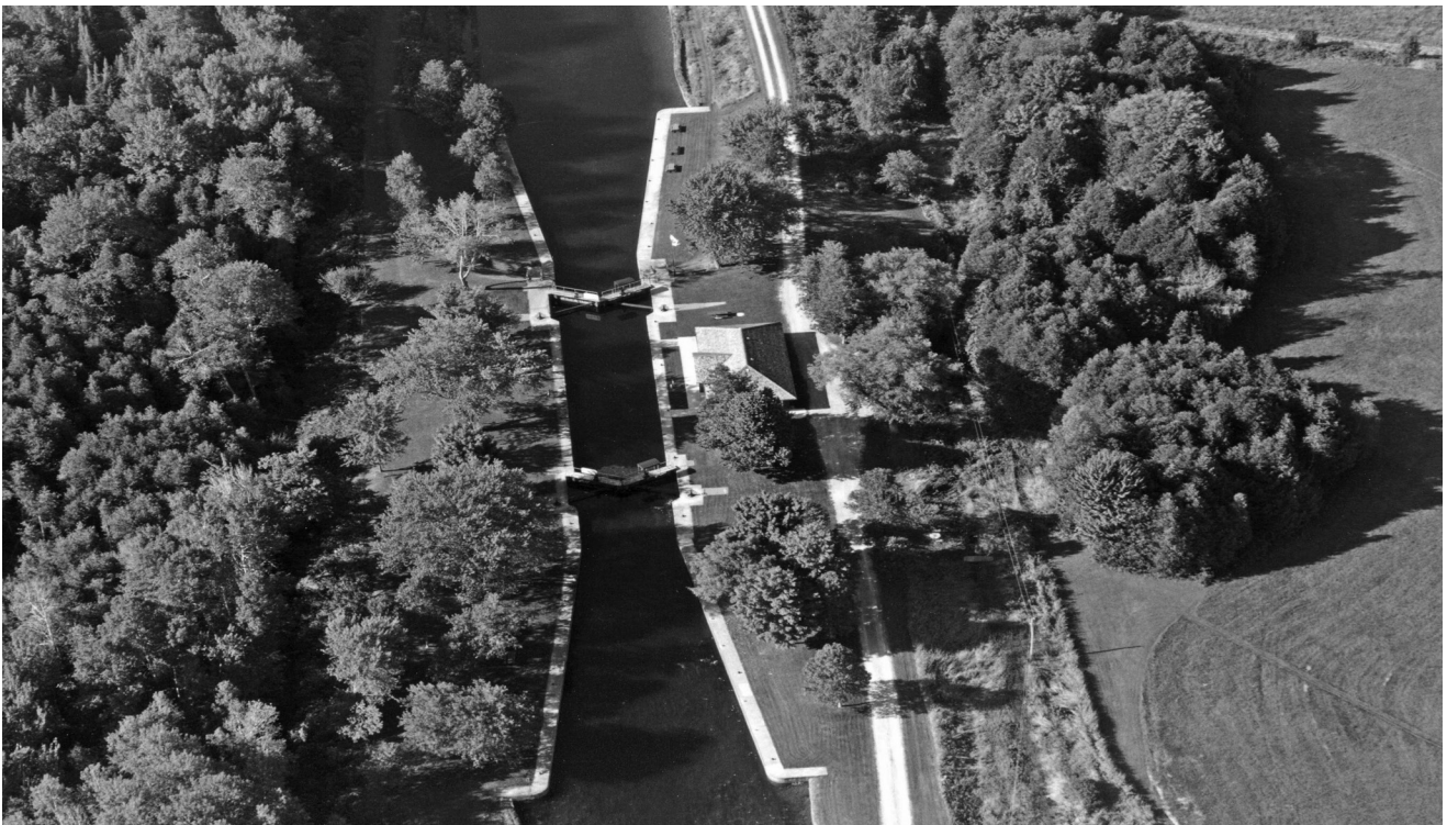
ÉCLUSE PORTAGE (ÉCLUSE N° 39) (2015)
