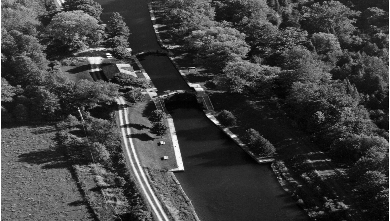
ÉCLUSE THORAH (ÉCLUSE N° 40) (2015)
