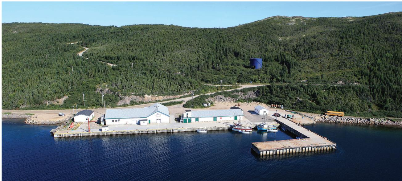
NE de Fishermen Point. D'une longueur de 40 m (131 pi), il offre une profondeur minimale de 4,5 m (15 pi) le long de la face externe, longue de 37 m (121 pi). Une **rampe Ro-Ro**, d'une largeur de 15 m (49 pi) et offrant des profondeurs variant entre 3,2 m (10 pi), est attenante et située du côté Sud du quai. Il y a une bâtisse attenante à l'enracinement du quai (*voir l'annexe*).
