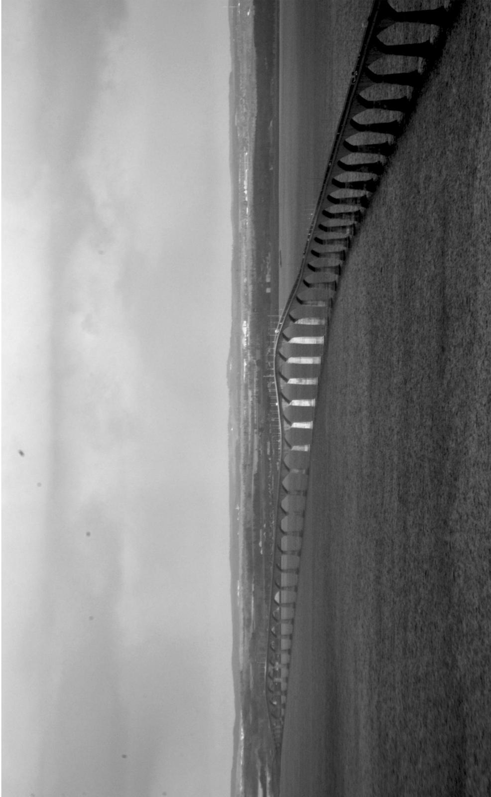
6 Le pont est constitué de 44 travées de béton et navigables. La jetée la plus à l'Est (côté de l'Île-du-Prince-Édouard) et la plus à l'Ouest (côté du Nouveau-Brunswick) sont respectivement les jetées 1 et 44.
