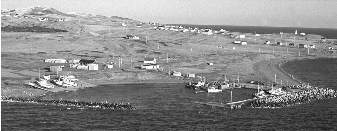
on y retrouve une **rampe de mise à l'eau**. Un autre **quai**, d'une longueur de 68 m et équipé de prises d'eau et d'électricité, forme le côté NW du bassin. Dû à l'ensablement continu,
