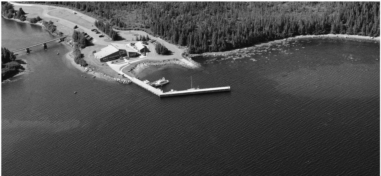
(180 pi) sur 5 m (16 pi); la face intérieure du tableau offre une profondeur utile de 1,8 m (6 pi) et la face extérieure, 2,4 m (8 pi). Un feu reposant sur un mât est placé sur l'extrémité du quai. Un ponton s'allonge depuis la section intérieure du côté Nord du quai Salton's. Une rampe de mise à l'eau est située près du quai. Le quai est équipé de prises d'eau et d'électricité et l'amarrage nécessite l'autorisation des autorités du parc; il y a une buanderette à proximité du quai.
