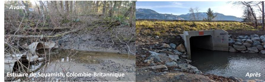
Le projet de rétablissement de l'habitat du saumon de l'estuaire Squamish est axé sur l'amélioration de l'accès et de l'habitat du poisson par le remplacement de ponceaux, le réaménagement d'une route sur digue et l'installation d'une structure de prise d'eau.
