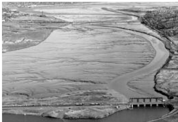
Figure 4. Vue de l'aval de la rivière depuis le pont-chaussée un an après la fin de la construction. On y voit les nouvelles grandes vasières qui se sont formées.
