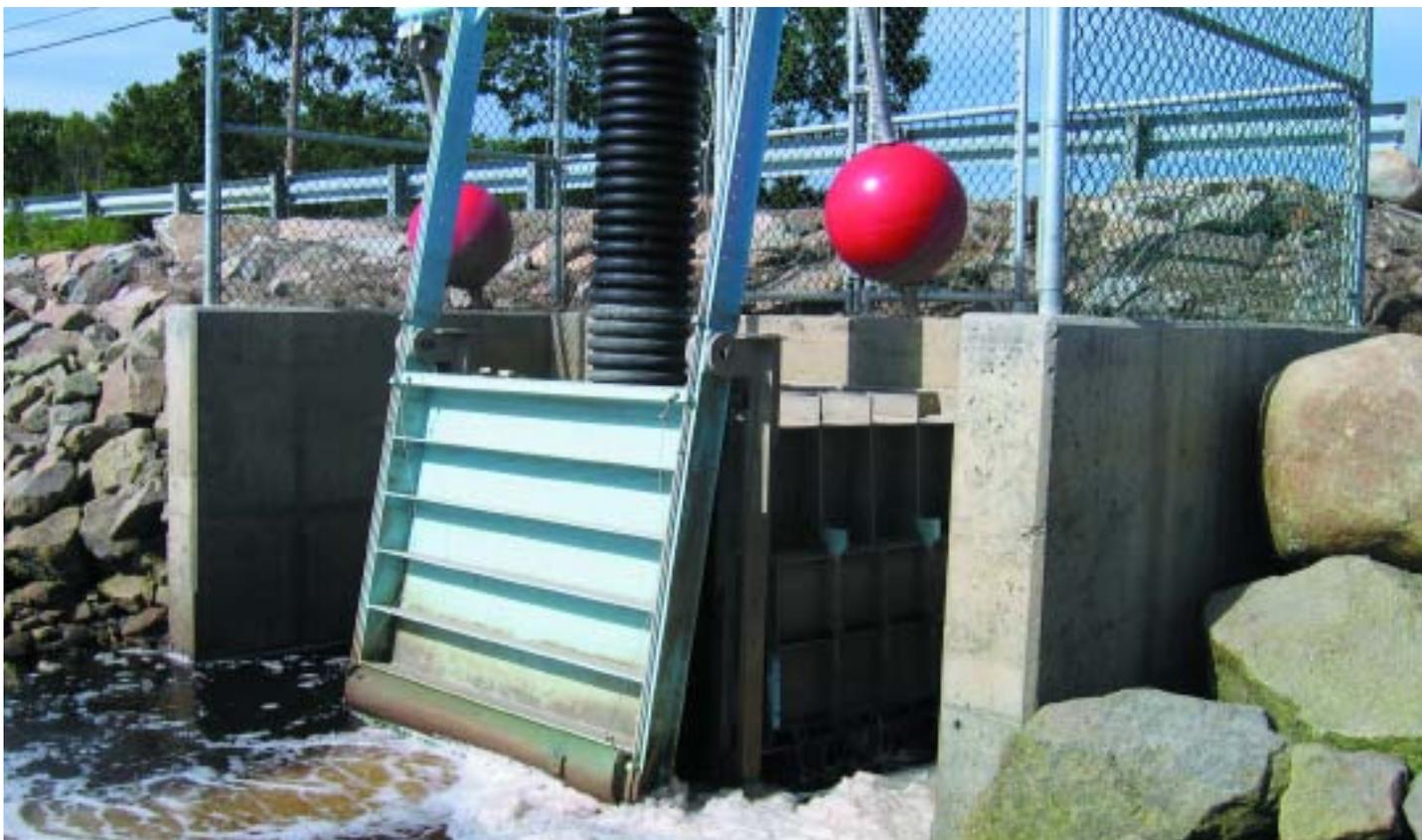
Clapet à marée autorégulateur permettant le passage du poisson – photo gracieusement offerte par Tony Bowron
