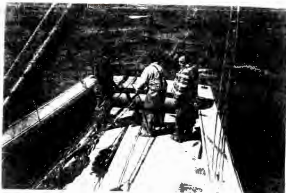
Photo 23 : On rentre le filet. Une fois qu'on a ramené les poids de lestage à bord du bateau n° 2, les funes sont ramenées à bord du bateau n° 1.
