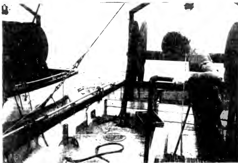
Photo 36 : Lorsqu'on rentre le filet, les deux bateaux s'arriment brièvement l'un à l'autre, le temps de transférer les funes du bateau n° 2 au bateau n° 1. Auprès du treuil simple, un membre d'équipage devait s'assurer que le câble s'enroule uniformément et se torde le moins possible.
