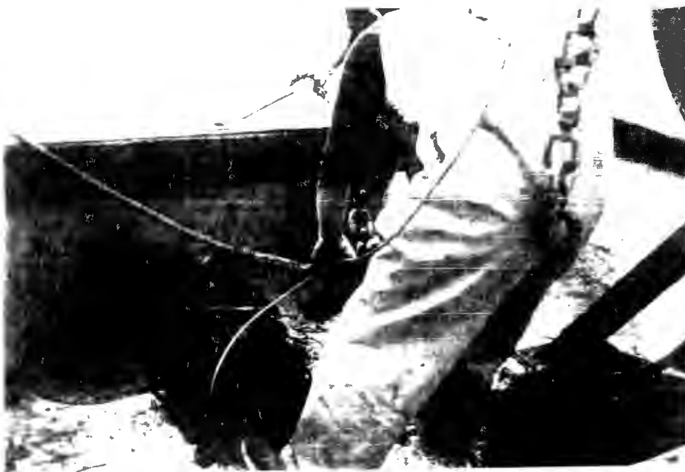
Photo 39 : On transfère les funes et on les attache au davier sur le dévidoir.
