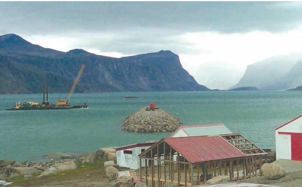
Aménagement d'un port à Pangnirtung, au Nunavut Photo : MPO
