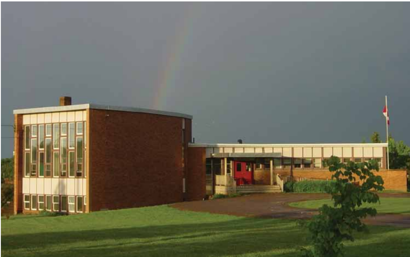
Le Tatamagouche Centre, à Tatamagouche (Nouvelle-Écosse), a accueilli l'atelier sur l'habitat. Photo du Tatamagouche Centre
