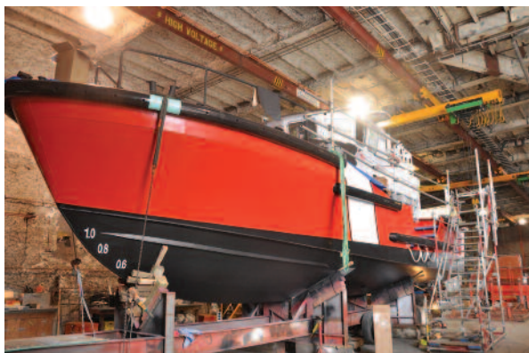
Un navire de la GCC en construction
